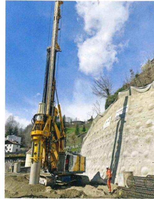
**SICHERUNGSMASSNAHMEN** Litzenanker vernagelte Spritzbetonwände und Großbohrpfähle kamen zum Einsatz.
