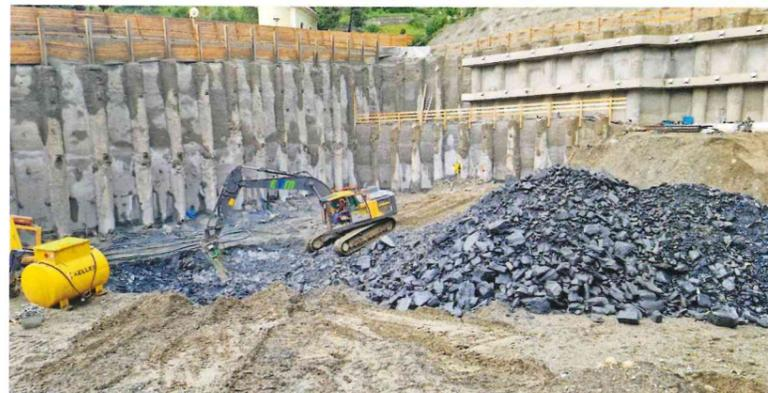
Im Straßenbereich hat die rückverankerte Bohrpfehlwand eine rein temporäre Funktion, bis zur Fertigstellung des Neubaus und der Hinterfüllung der Baugrube. Der talseitige Bereich in Richtung Bestandsklinik und der örtlichen Kirche bot einen gewissen Platz für Baugrubenböschungen. Hier wurden temporäre, vernagelte Spritzbetonwände mit bis zu acht Metern Höhe errichtet.
